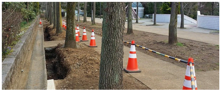
根を切断しコンクリートで防壁構築（平成28年3月21日）
