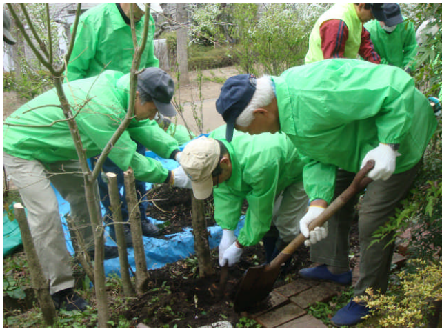
1号棟北側の生け垣植え替え作業1日目 (3月24日)
