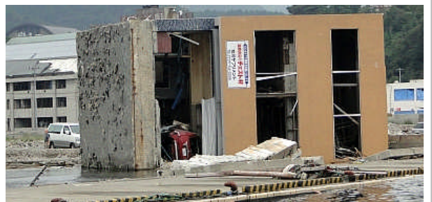
横転して流された3階建てのビル
